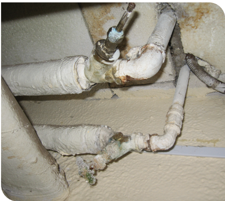
hibás szabályozó szelepek a melegvíz-hálózaton
