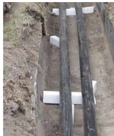
Új távvezeték építése
